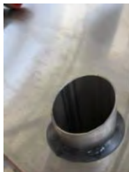
Fig. 53: Montering av dubbelmuffen
