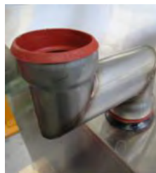
Monterad dubbelmuff med silikonringar
